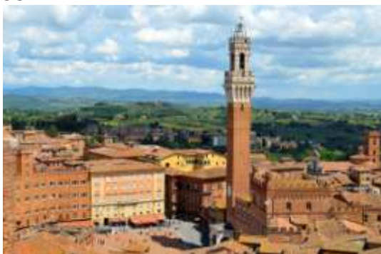
Siena, Torre del Magnia, byggt 1338-1348, 88 m
